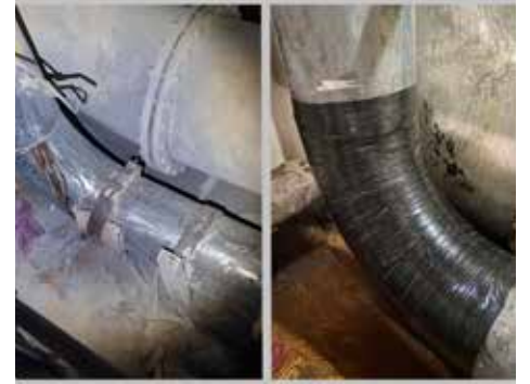
Belzona SuperWrap II ile aşınmış borunun onarımı
