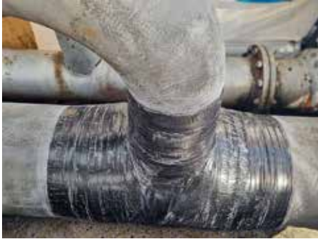
Belzona SuperWrap II ile boru tesisatının dayanıklılığı geri kazandırılıyor
