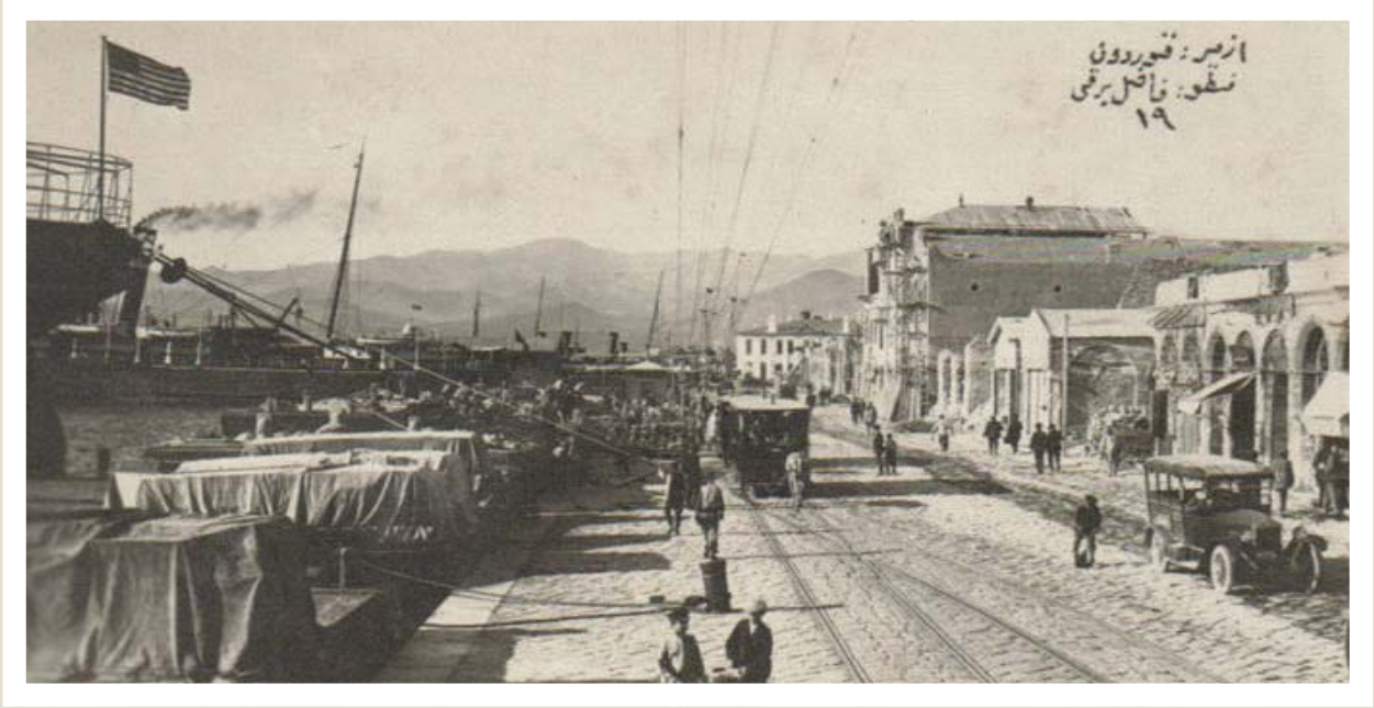
(Üstte) Kordon Boyu ve (Altta) Pasaport rıhtımları; Tam olarak eski limanın gümrük binasıdır, Günümüzde Konak Pier alışveriş merkezidir ve etrafında nezih cafeler, restoranlar yer almaktadır. Birkaç sene öncesine kadar o bölge Gümrük olarak adlandırılırdı. Konak Pier AVM'ne dönüşmeden önce ise balık hali olarak kullanıldı. Binanın mimarı Paris Eiffel kulesi mimarı Gustave Eiffel'dir. Kaynak: Sabah & Joaillier
