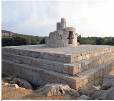
Patara Deniz Feneri Podyum Onarımı
