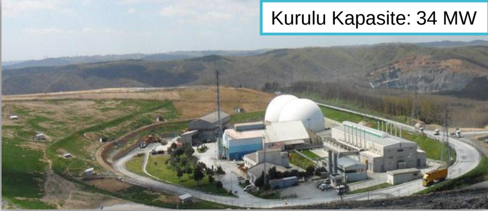
Odayeri Çöp Gazı Enerji Üretim Tesisi
