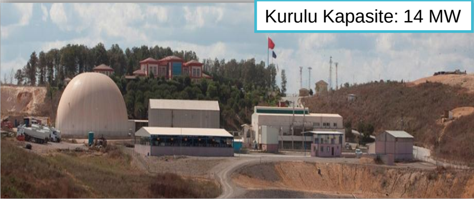
Kömürcüoda Çöp Gazı Enerji Üretim Tesisi
